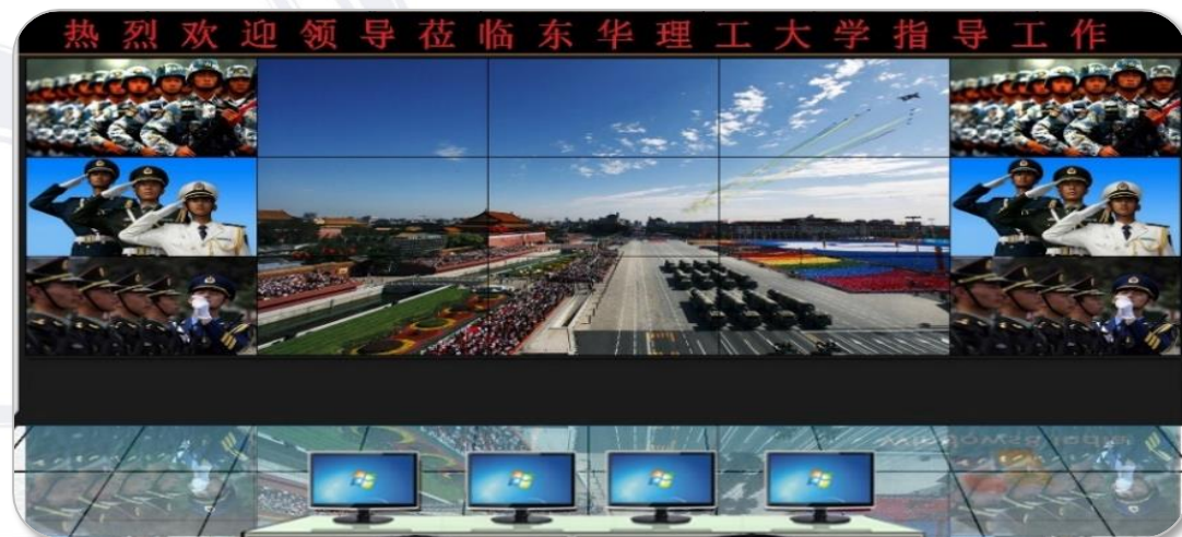
网络安全运维监控中心
